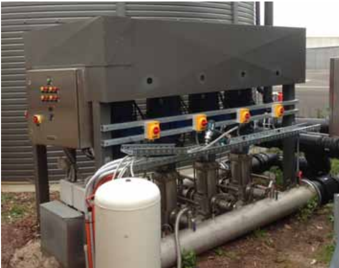
KATKO VSD EMC Trenner am Sydney International Airport installiert, als Teil von zwei Santerno Multipumpen-Systemen für ihre mit recycletem Wasser behandelten Pflanzen
