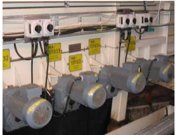
KATKO SICHERHEITSSCHALTER bei UPM Rauma Papierfabrik, die in Finnland mit der neuesten Papiermaschine startet
